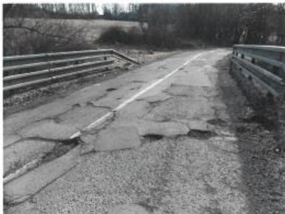
Obrázok 45 Porušený asfaltový kryt na moste 527-036
